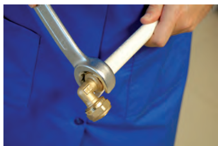
4. Ajustar la unión usando una llave inglesa 4. Ajustar a união com uma chave inglesa
