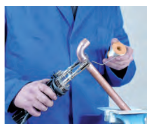
5. Aplicación de la soldadura 5. Aplicação da soldadura
