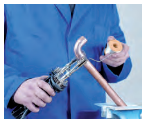
5. Aplicación de la soldadura 5. Aplicação da soldadura
