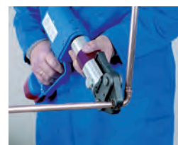
6. Prensado 6. Prensado
