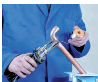
5. Aplicación de la soldadura 5. Aplicação da soldadura
