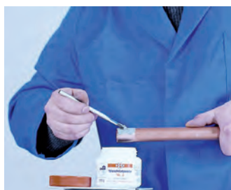
4. Aplicación del decapante 4. Aplicação do decapante
