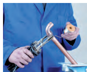
5. Aplicación de la soldadura 5. Aplicação da soldadura
