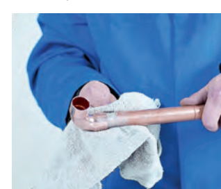
6. Limpieza final 6. Limpeza final
