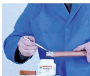
4. Aplicación del decapante 4. Aplicação do decapante
