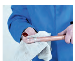
6. Limpieza final 6. Limpeza final
