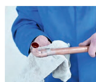
6. Limpieza final 6. Limpeza final
