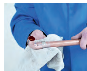
6. Limpieza final 6. Limpeza final
