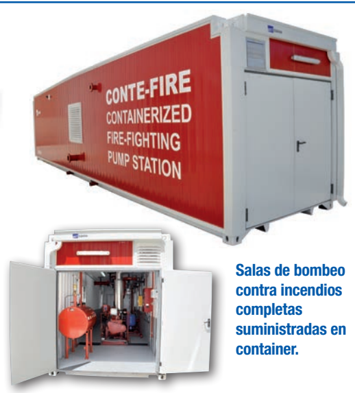
Equipos contra incendios con bombas de cámara partida. Norma NFPA 20.
