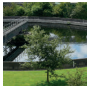
Tratamiento de agua
