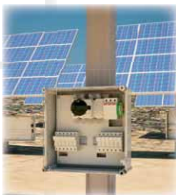
Cuadros Nivel 1 y Nivel 2 para instalaciones Fotovoltaicas.
