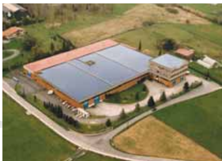
Vista aérea de las instalaciones en Lezama (España)
