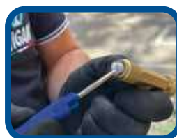
Extracción de junta
