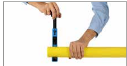
3. Cortar el tubo de forma totalmente recta.
