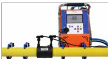
11. Inicio de la soldadura.
