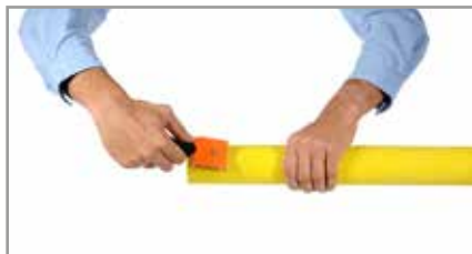
5. Rasar la zona de soldadura del tubo.
