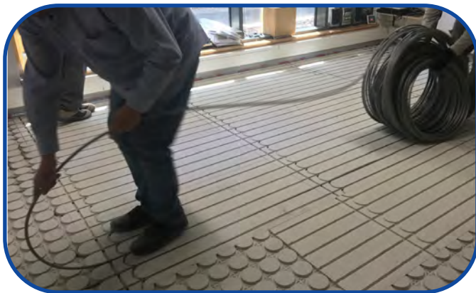
5.- Colocación tubo de los distintos circuitos.
