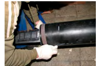
4. Limpiar y lijar el área donde va a ir la camisa.
