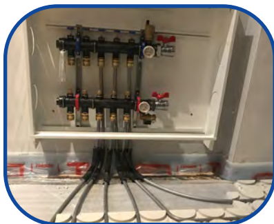
5.- Colocación tubo de los distintos circuitos.
