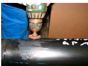
13. Repasar los orificios con una broca.
